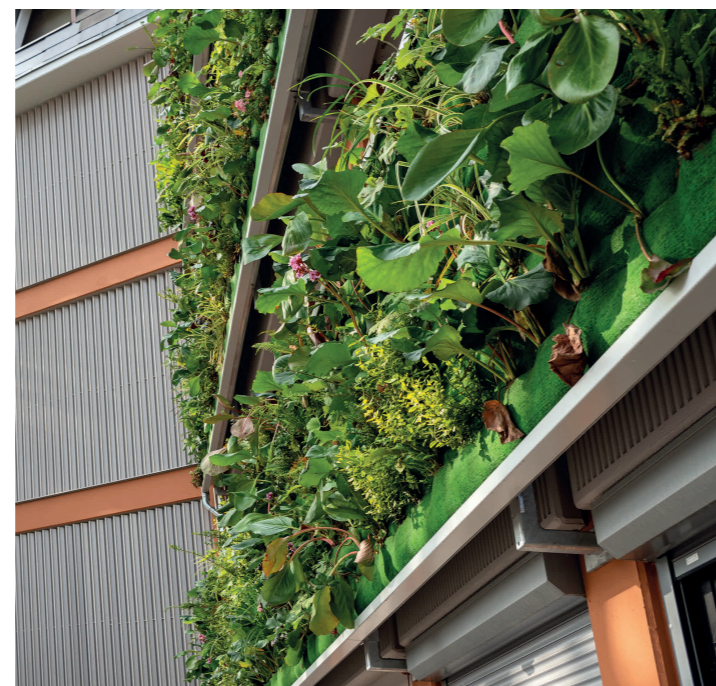
Hier gut zu sehen: Die vor die Betonfassade gehängte Unterkonstruktion aus Aluminiumprofilen und eine Auffangrinne unter den Pflanzen.
