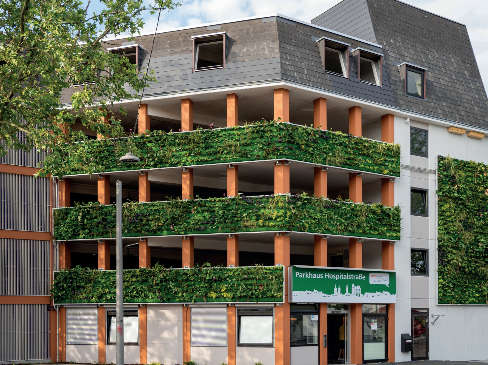
Pflanzen statt nackter Betonwände: An diesem Parkhaus in Göttingen wachsen jetzt Gräser und Stauden in vertikalen Beeten.
