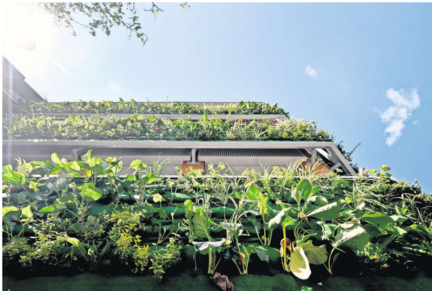
Das Parkhaus an der Hospitalstraße hat auf der Wochenmarktseite vertikale Beete.
